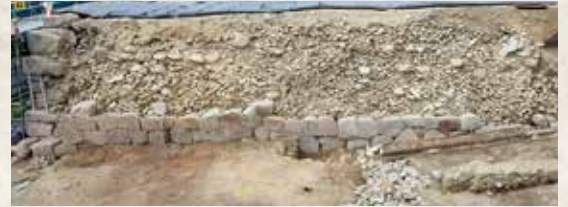
側壁石垣の検出状況(北)
