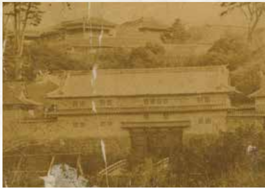
明治初期の鼠多門・鼠多門橋(背後は二の丸御殿) (「金沢城門等写真」金沢市立玉川図書館蔵)
