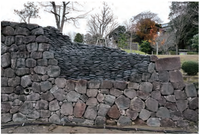
②玉泉院丸南石垣 変形箇所の解体調査を実施
