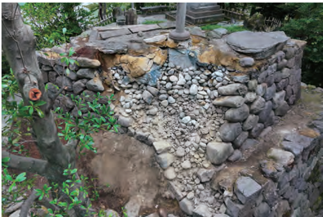
⑤栄螺山石垣 変形石垣の解体を実施
