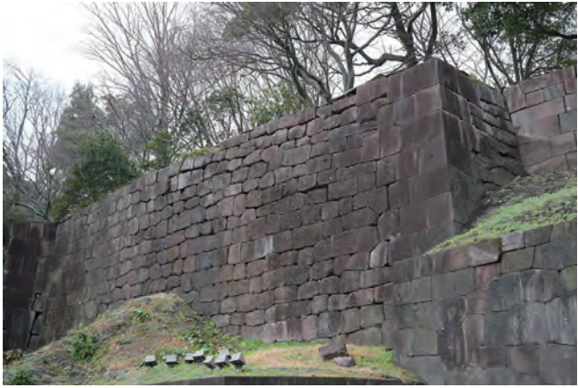
⑧御居間先下石垣 解体調査に先行し上面遺構調査を実施
