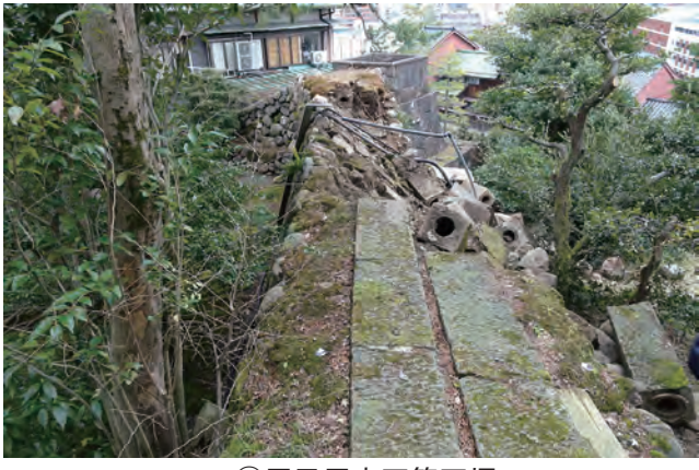
⑦辰巳用水石管石垣 崩落石材の回収・同定を実施
