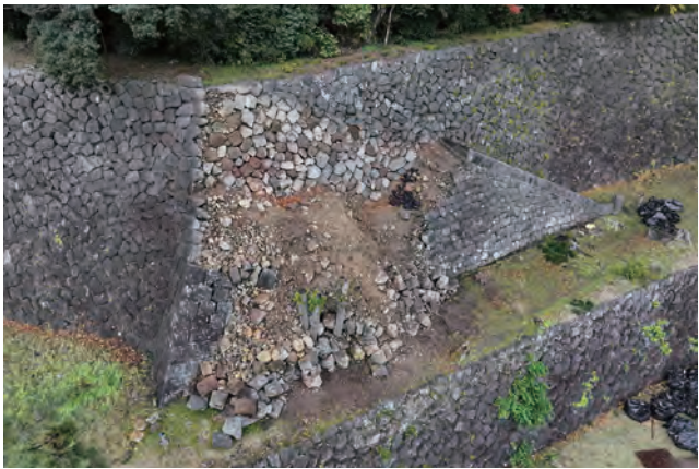
⑥本丸南石垣 解体調査と崩落石材の回収・同定を実施
