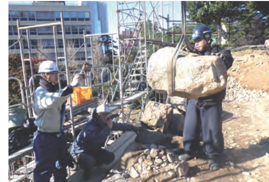
変形箇所の石垣解体調査
