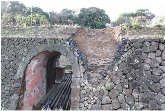
③本丸北石垣 変形箇所の解体調査を実施
