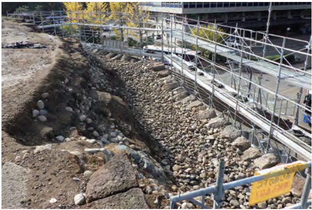
④玉泉院丸南西石垣 変形石垣の解体と未修理範囲の解体調査
