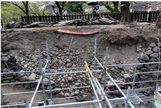
①石川門前土橋石垣 変形箇所の解体調査を実施
