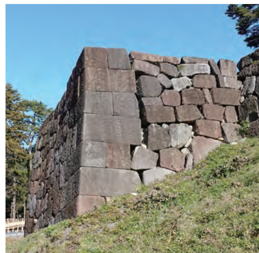
隅角部と築石部の間に亀裂が入るように変形（赤：地震前）
